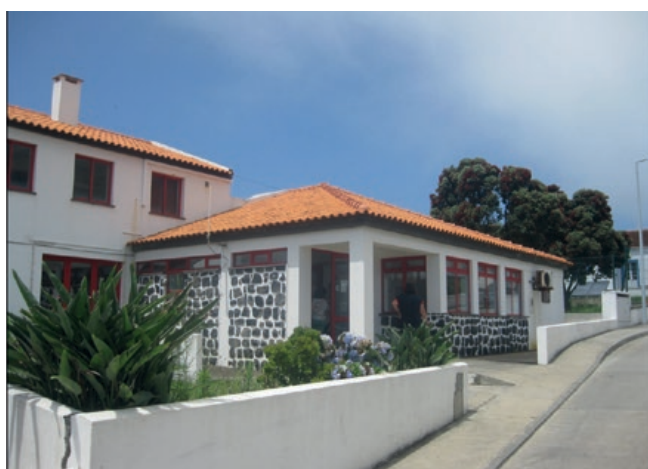
Figura 8 - Edifício da Unidade de Saúde do Corvo.
